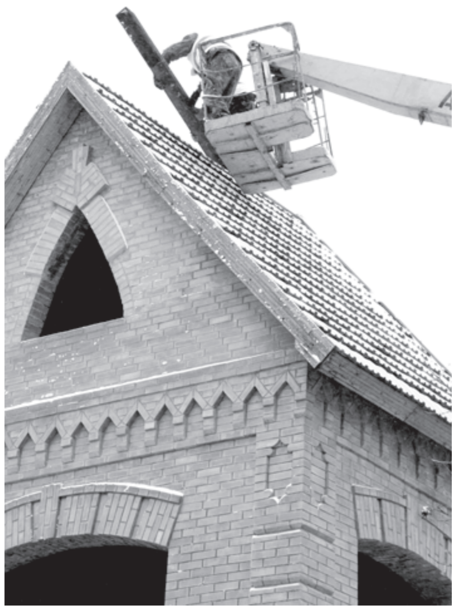
Начат снос незаконной постройки.
