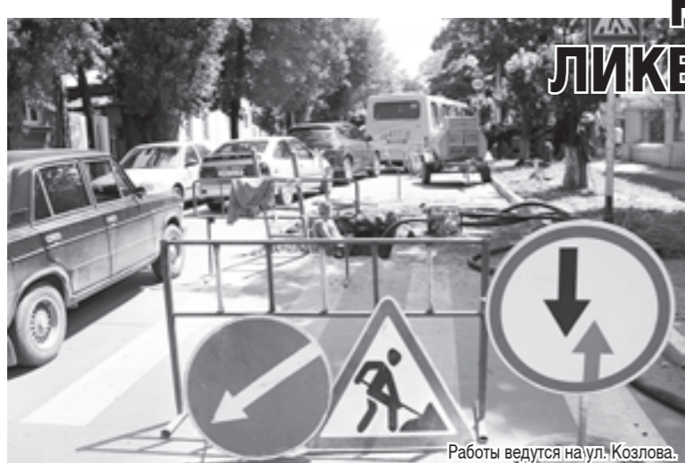
Работы ведутся на ул. Козлова.
