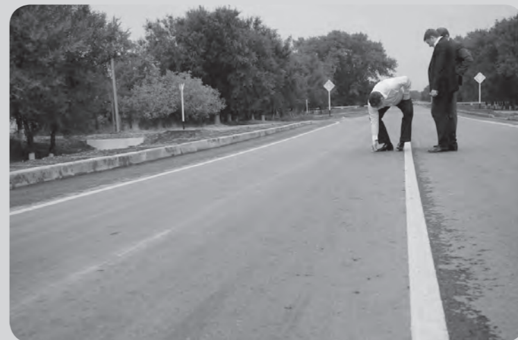
Ремонт дорог в Ставрополе. Качество выполненных работ глава края проверяет лично.
