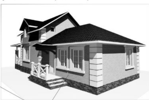
Существующий дом, утеплили, облицевали кирпичем, заменили кровлю
