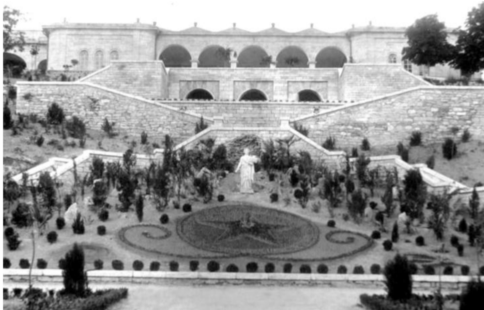
Лестница П. Еськова. В центре статуя богини Прозерпины. 1935 г.
